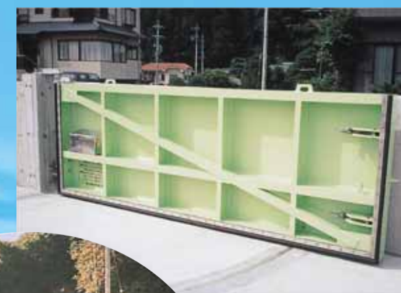
●天竜川北鹿島第2陸開 (国土交通省) 銅製プレートガータ式 スイングゲート 3.5m×1.3m
