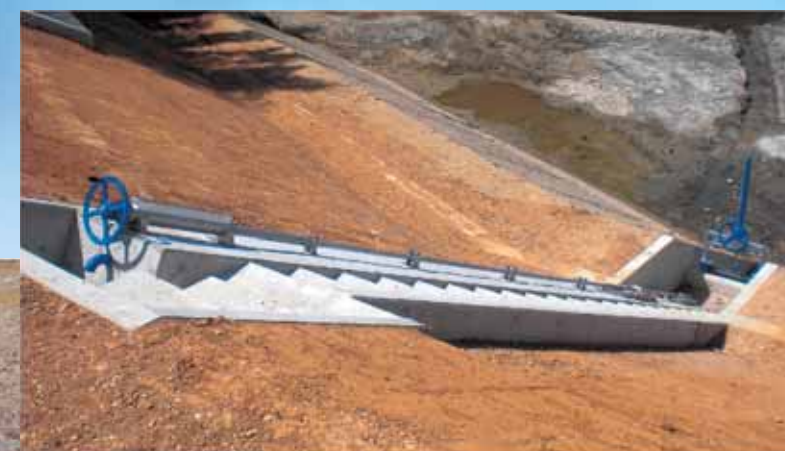
●桑名市深谷部 (桑名市農政環境事務所) 斜樋ゲート 23L 1連 φ200mm×φ300mm 底樋ゲート 1門 0.8m×0.8m
