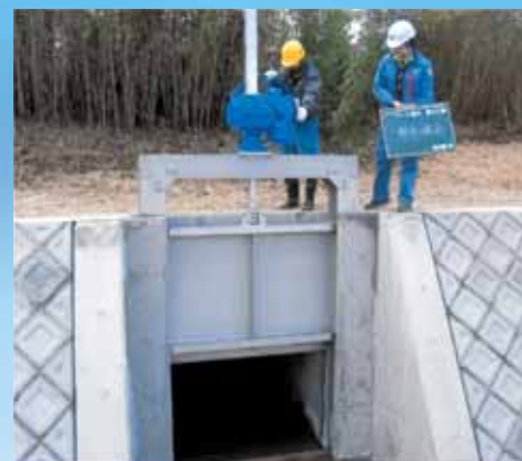
●四日市市中村町 (四日市市農林商工環境事務所) ステンレス製スライドゲート 1.5m×1.0m
