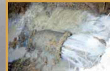
▼ダクタイル管の継手漏水
